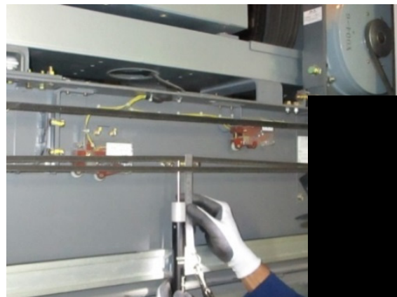
写真 1-16-1 連結（連動）ロープの検査例
