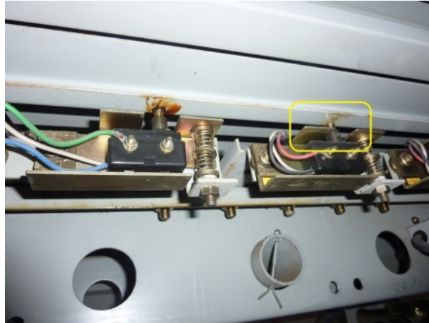
写真 1-14-2 はかり装置の作動を検出スイッチにて行う例
