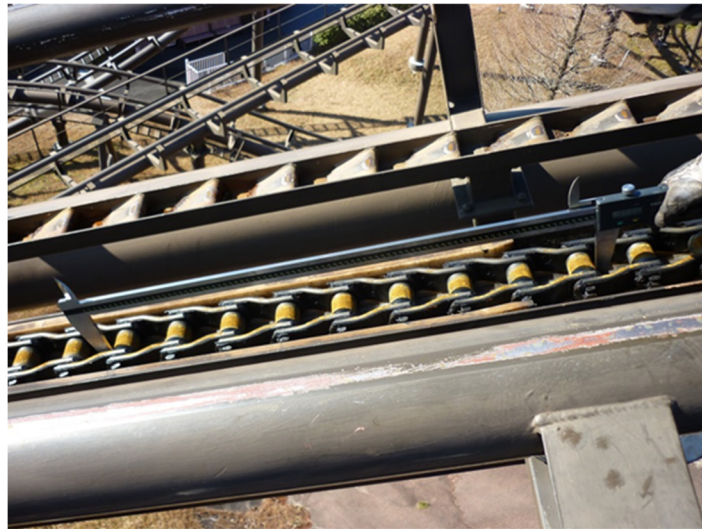
写真 3-3-1 長尺ノギスを使用した伸びの測定
