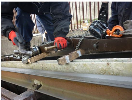
写真 3-2-1 軸(ピン)を叩いてチェーンリンクを分解する方法
