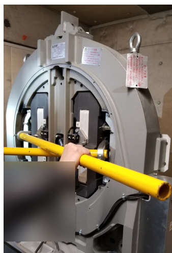
写真 1-2-1 a) ブレーキ開放装置により確認している例 （かごと釣合いおもりのアンバランスを利用し動くことを確認）
