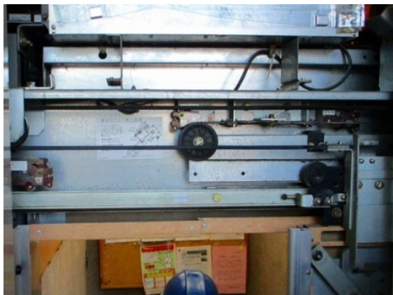
写真 1-16-1 連結（連動）ロープの検査例
