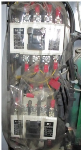
写真 1-3-2 分解しなければ接点の確認ができない接触器の例
