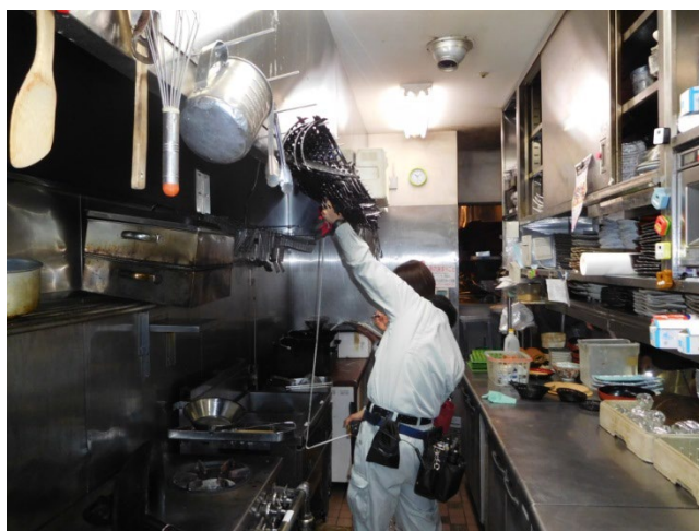
火源等から排気フードの下端までの高さの計測状況
