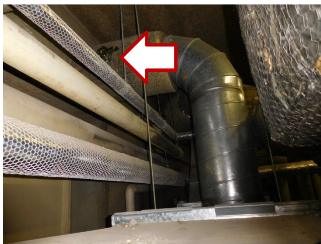
防火ダンパーに吊り金具が設けられていない事例
