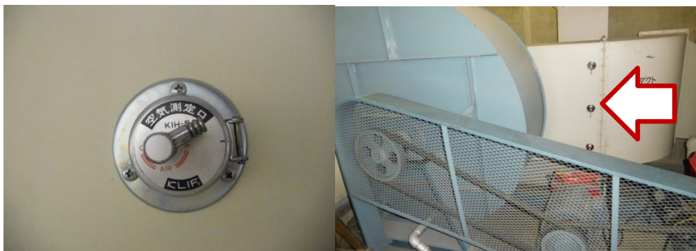
直管部分が短い風道に設けられている空気測定口の例
